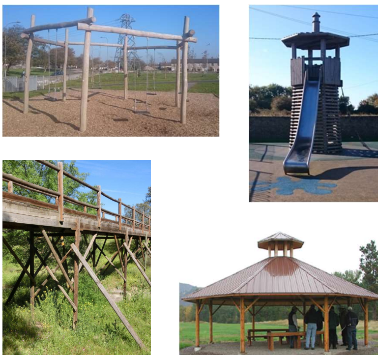
Fig. 4 : End-uses of round timber: playgrounds (a,b), footbridge (c), kiosk (d)
