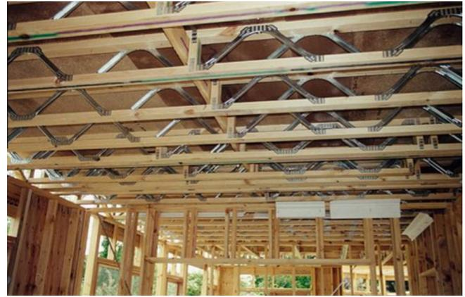
**Fig. 13.** Metal web joists (Mitek Posi-Joists).
